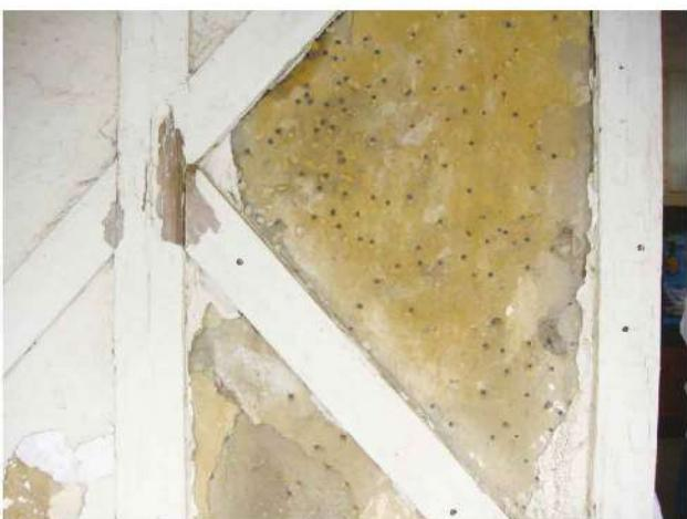
特殊的「編泥牆」做為牆壁，而牆壁內以竹子、黃泥、稻草、石灰等攪拌而成，形成一大特色，在台灣鐵路文化史上已不多見。
